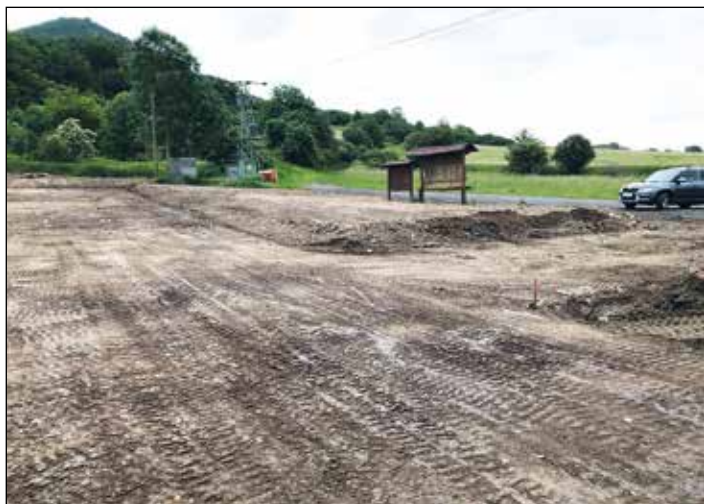
Budování parkoviště pod Lovošem
